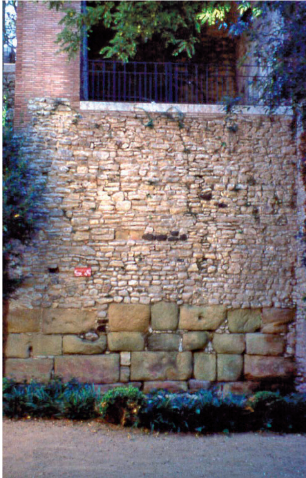
FIGURA 7. Cara interior de la torre número 3 (també coneguda com del Telègraf Òptic o del Llamp). La fonamentació és obrada amb material d'aprofitament, gres i marbre, i la superior amb blocs menuts de calcària.
