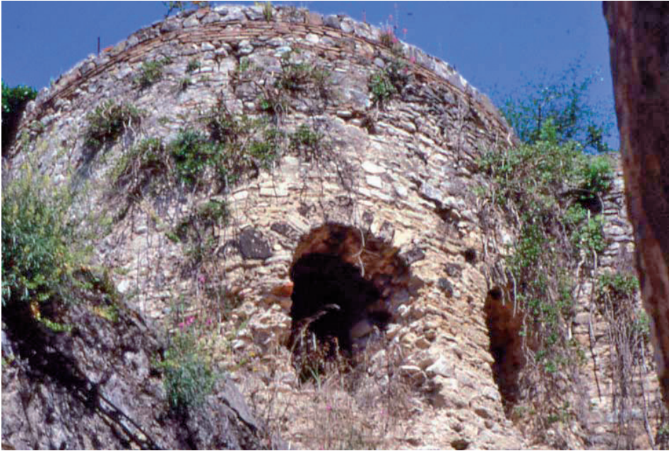
FIGURA 5. Part superior de la torre número 8, també coneguda com a vescomtal o d'Agullana, amb els finestrals amb arc de mig punt i la utilització de dovelles de pedra de diferent color.
