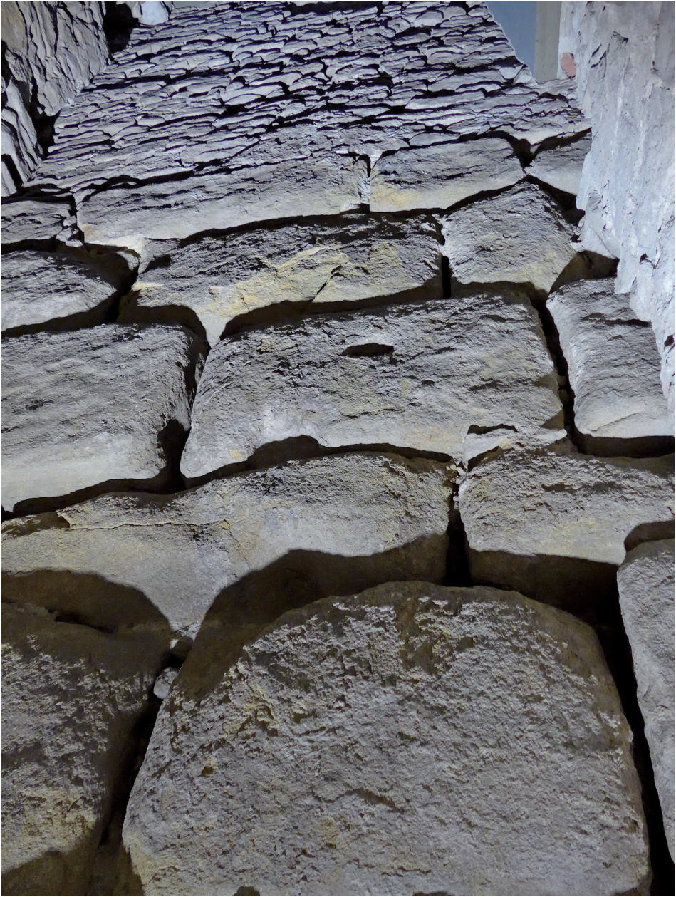
FIGURA 12. Torre número 12. Estat actual del parament nord, amb grans carreus de gres d'aprofitament que conformen les filades inferiors i l'ús de blocs menuts que conformen la part de dalt.
