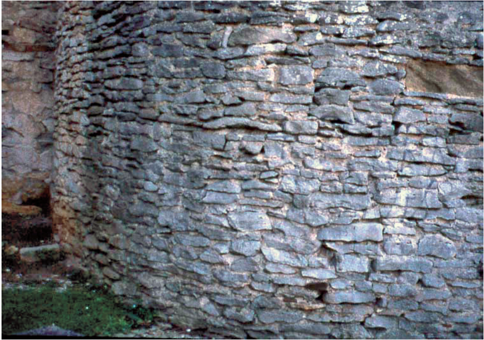
FIGURA 3. Detall de la tècnica constructiva de la muralla carolíngia. Sector septentrional, zona del claustre de la seu.
